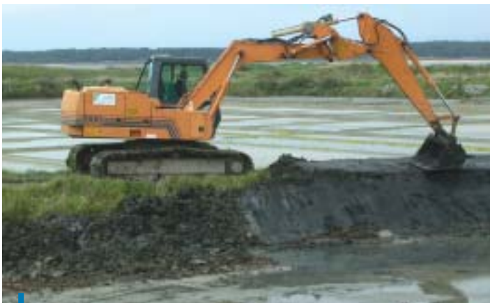
Restauration des levées d'une saline de Guérande.
