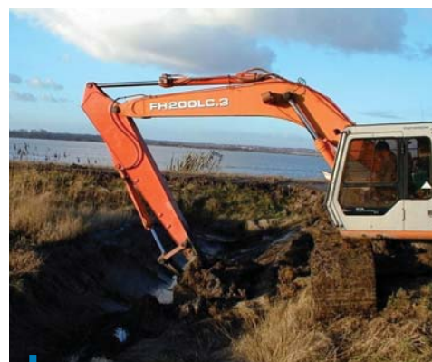
Travaux de curage à Lupin - Estuaire de la Charente. (Photo : FMA).
