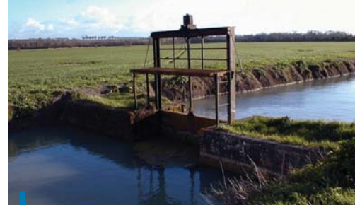
Ouvrage hydraulique à Loire-les-Marais (17). (Photo : FMA).
