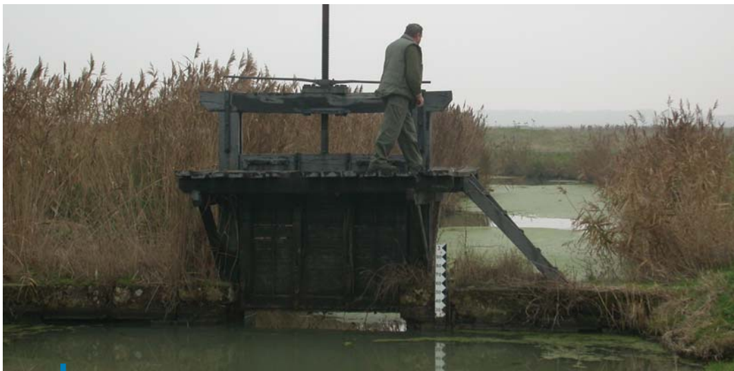
Maniement d'une écluse dans les marais de St Agnant (17). (Photo : FMA).
